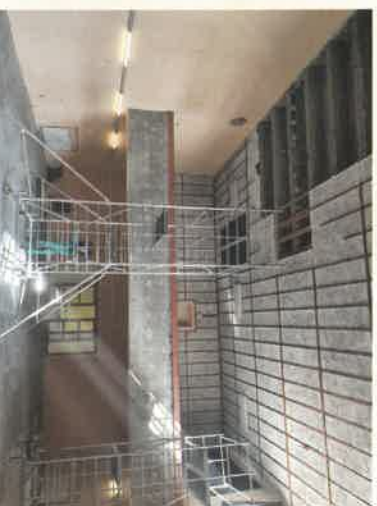
oprava elektroinstalace v Kulturním domě Těšetice • dotace MMR
